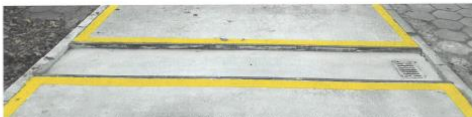
Rys. 1. Zagłębienie pod wagi przenośne typu SAW10C III w kształcie zamkniętej rynny ze studzienką odwadniającą.
